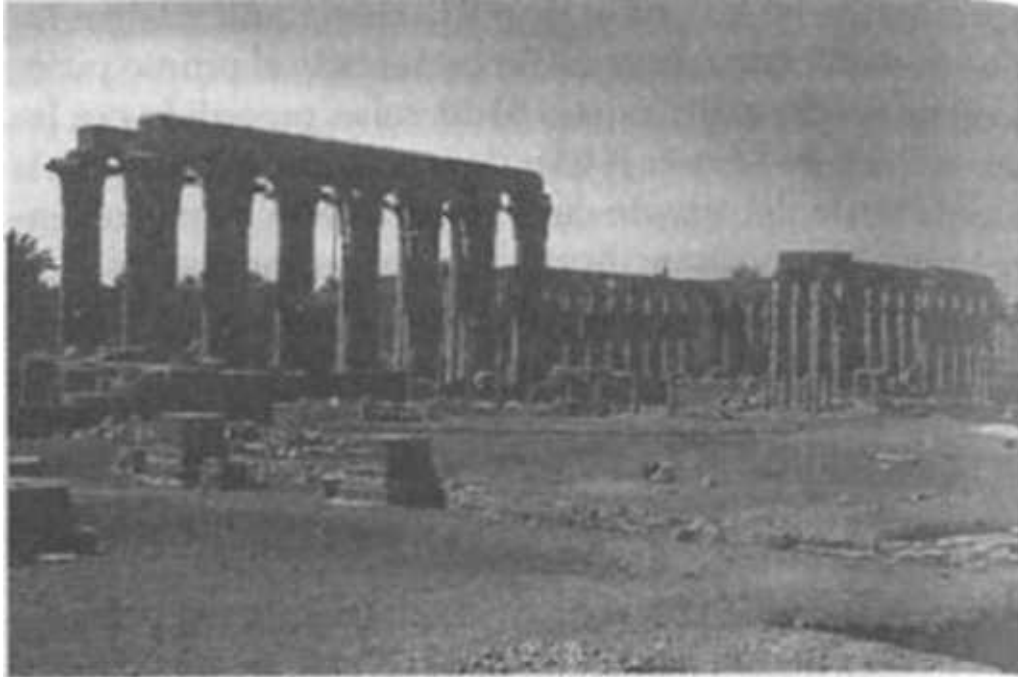
Luxor. La columnata que da acceso al patio de Amenofis III. Es uno de los lugares donde de un modo más directo se percibe el carácter sagrado de la geometría egipcia y la luz inscrita en la piedra por los Maestros de Obra.
